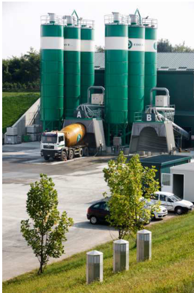
Foto 2 – Impianto di produzione c.l.s. nell'area di studio
