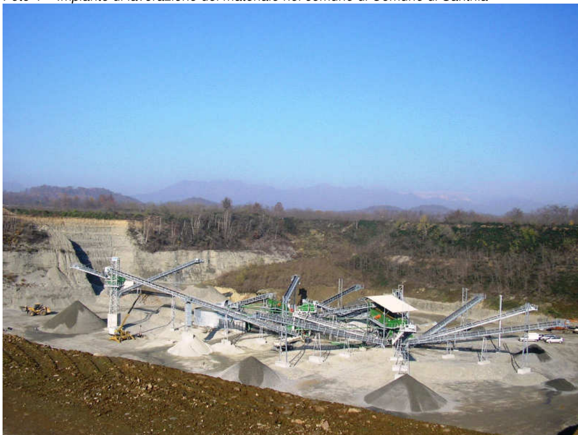
Foto 4 – Impianto di lavorazione del materiale nel comune di Santhià
