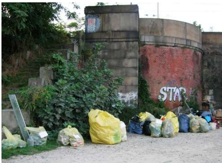
Rifiuti raccolti al ponte sul Sesia
